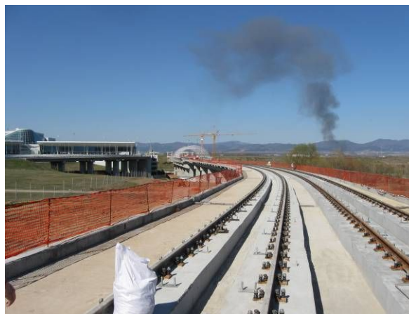
Фиг. 14. Изпълнение на метротрасето между МС „Софийска Света гора”, и МС „Летище София”
