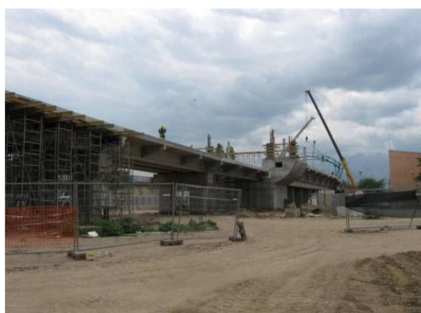
а) Изпълнение на естакадата
