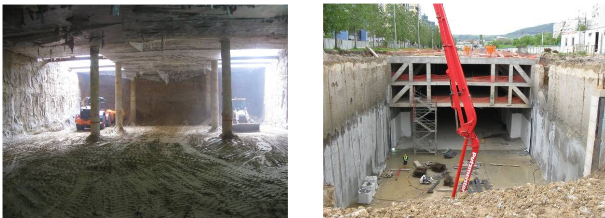
Фиг. 22. Строителство на МС „Бизнеспарк”
