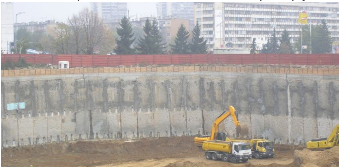
Фиг. 31. Укрепване със шлицови стени в гъсто застроена среда
